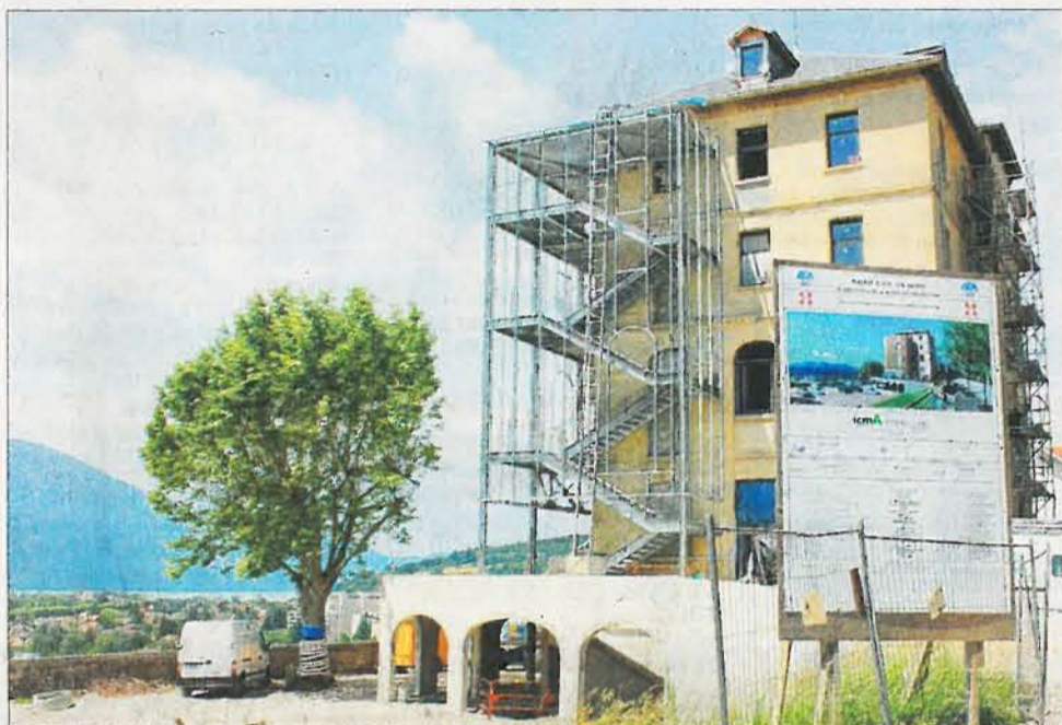
On voit la structure métallique qui couvre l'est, le sud et l'ouest de la façade. Celle-ci sera ensuite recouverte de plaques de métal poudrées et ajourées, passant du doré au rougeoyant selon la lumière.
