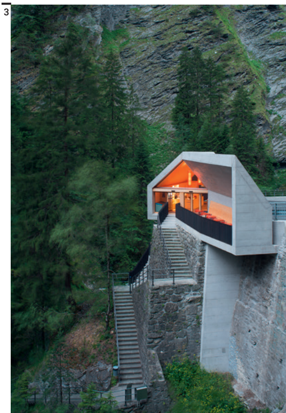
Fig. 3-4 Viamala Visitor Centre. Il centro si presenta da un lato come vetrina dei prodotti locali, con uno spazio di vendita al suo interno; dall'altro, come punto di partenza per le escursioni. Ivano Iseppi e Stefan Kurath, Iseppi-Kurath GmbH, 2014 (foto Laura Egger).
